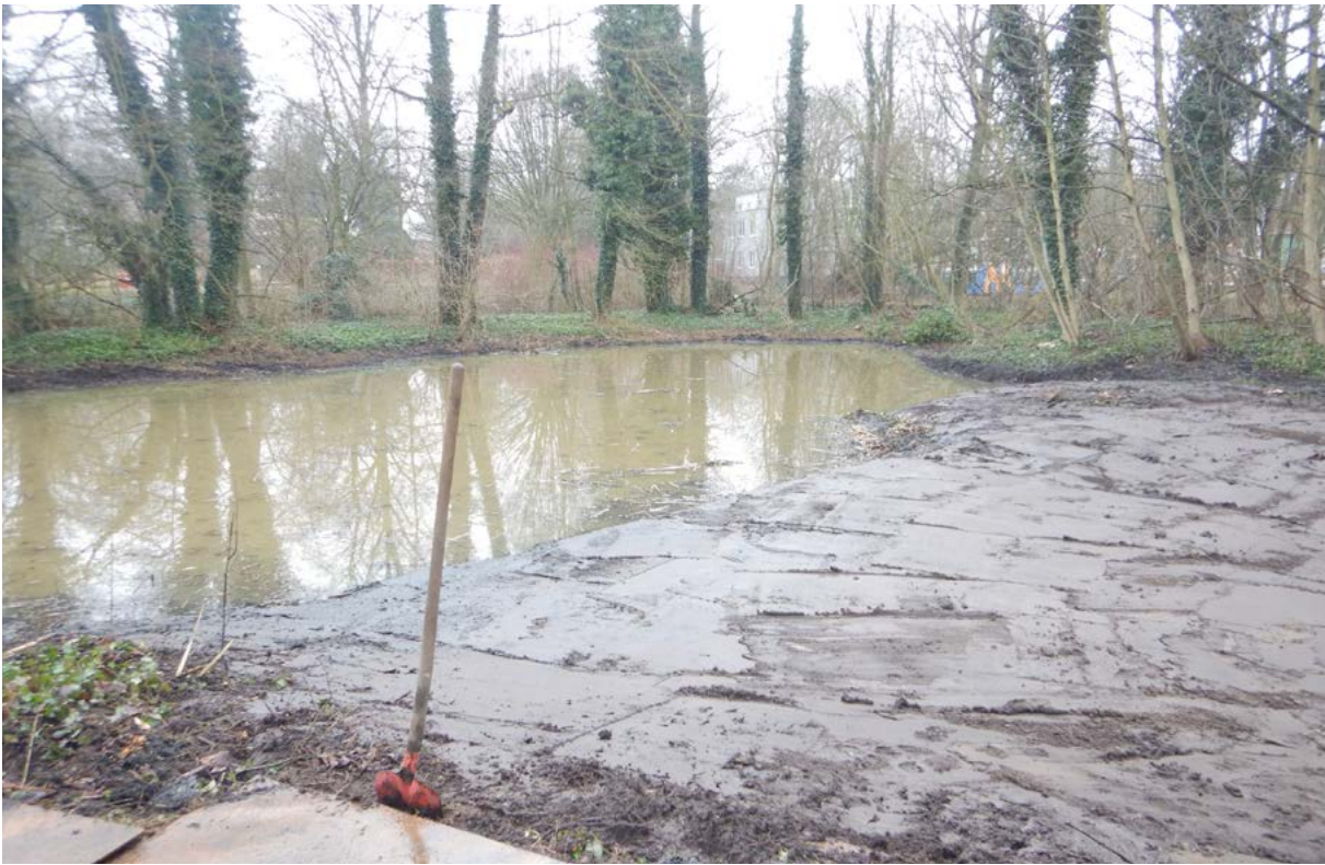
Abb. 7: Während der Herstellung im Rahmen einer Entschlammung Januar 2022 – © PLANULA 2022
