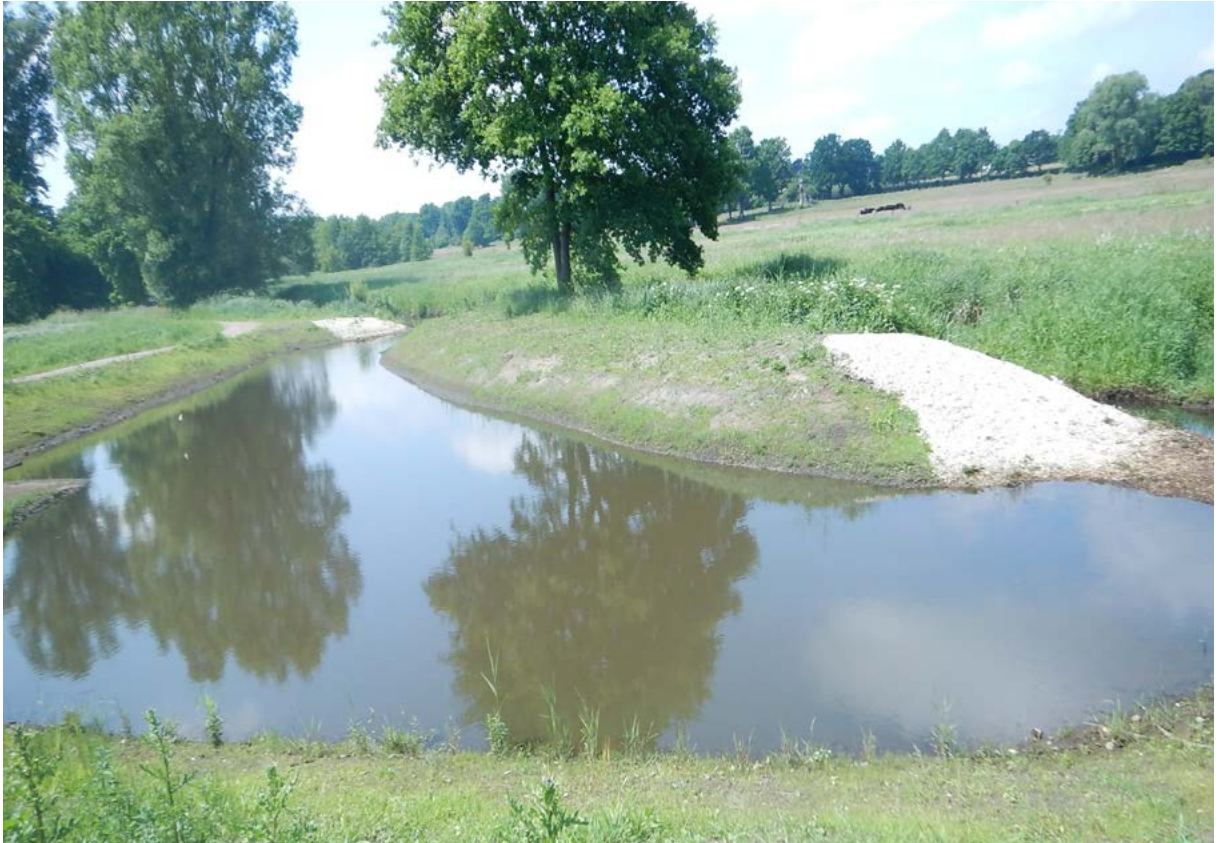
Abb. 15: Sandfang im Nebenschluss Wedeler Au einen Monat nach der Fertigstellung – © PLANULA 2022
