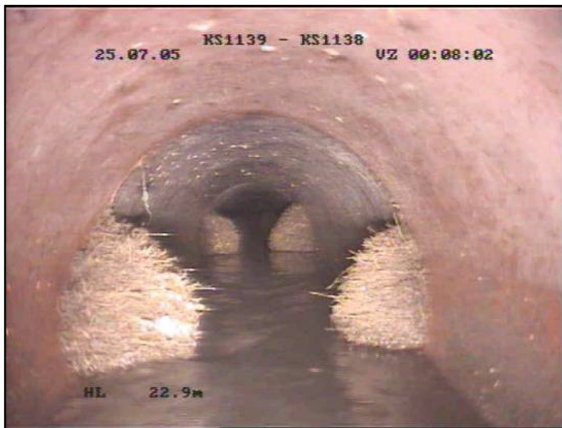
Wurzeleinwuchs [Backnang, 2014]
