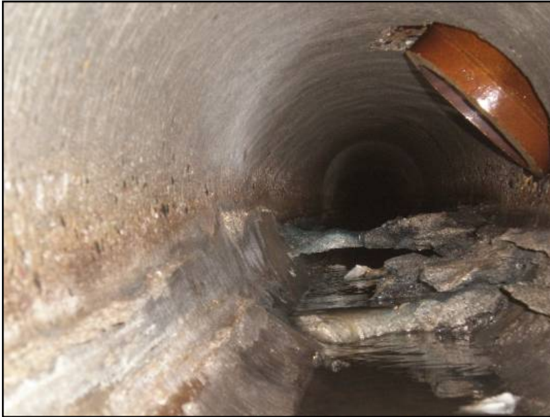
Einragender Stutzen [Vordereifel, 2014]
