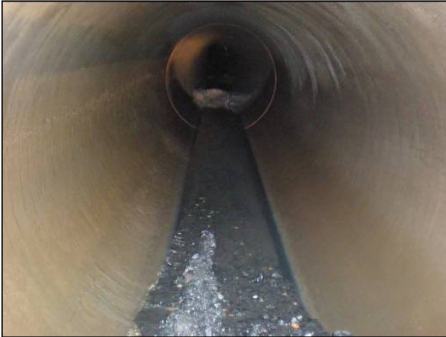
Geringes Sohlgefälle [Vordereifel, 2014]
