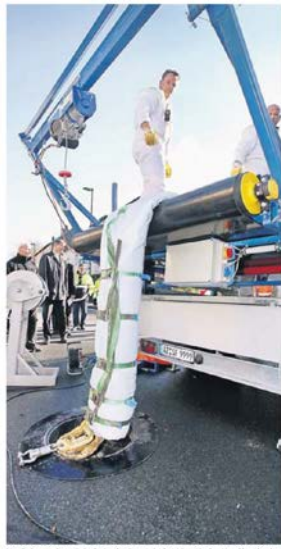
Veralteter Archivan-Behälter beschützt, wie der „Liner“ in den Kanal hinabgelassen wird. Die weiße Folie ist Schutz vor dem Sonnenlicht. (sob) ANHANG
