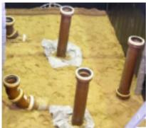
Sanierungsaufgabe: Sanierung von je drei Schadensbildern in einem nicht-sanierenen Beton- und Steinzeughauptkanal (DN 300)
