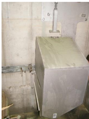
c) Einbringen der Haube mittels Kran
