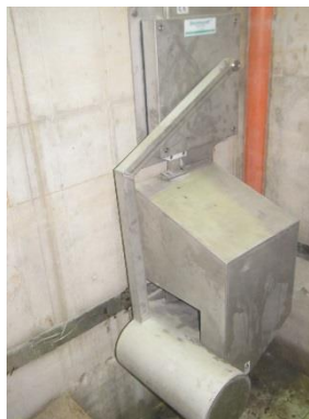
d) Anbringen des Schwimmers
