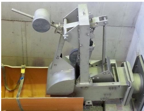
a) Strahl-Drossel im Trockenwetterzustand b) Strahl-Drossel in Betrieb
