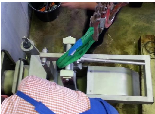
c) Einbringen des Drosselorgans mittels Kran
