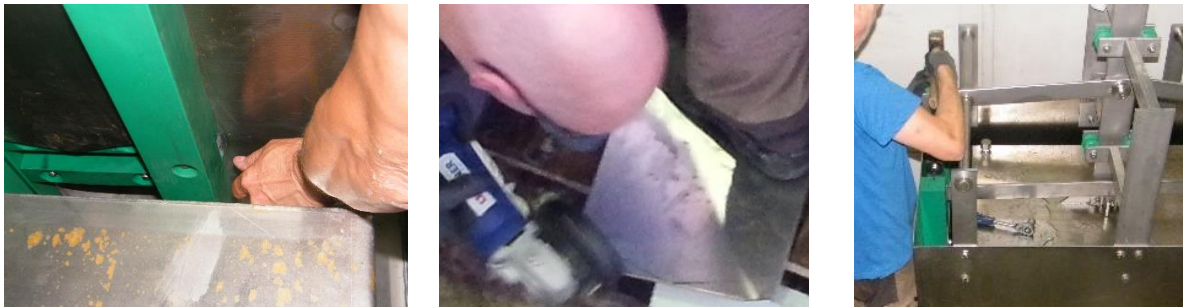
a) Verschließen einer Spülöffnung b) Ändern der Schiebergeometrie c) Kontrolle des Gestänges Bild 23 Wesentliche Arbeitsschritte für die Umstellung der Drosselwassermenge
