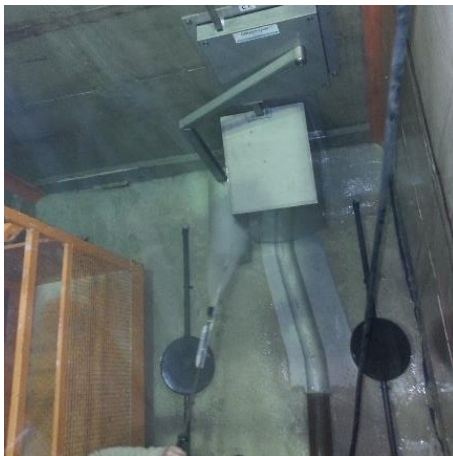
a) Hochdruck-Reinigung der Drossel
