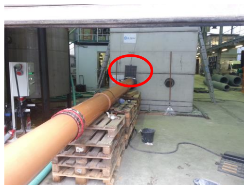
b) Ablaufleitung mit Schieber (roter Kreis)
