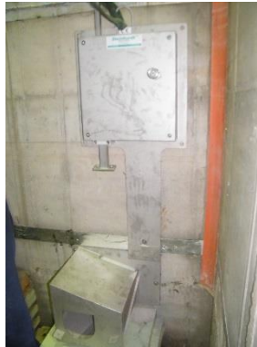
b) Steuerungskasten bereits montiert
