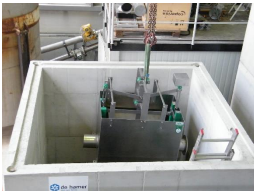
c) Einbringen des Drosselorgans mittels Kran
