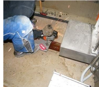
c) Kürzen der Schieberkanten
