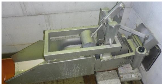
a) Waage-Drossel im Trockenwetterzustand
