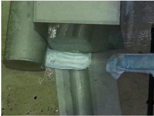
a) Verlegung durch Windel
