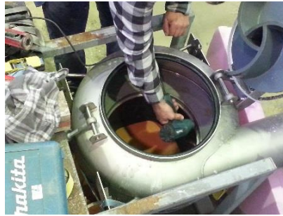
a) Herausschneiden der Blende b) Aufbringen des Klebers c) Vergleich der Querschnitte Bild 64 Wesentliche Arbeitsschritte für die Umstellung der Drosselwassermenge
