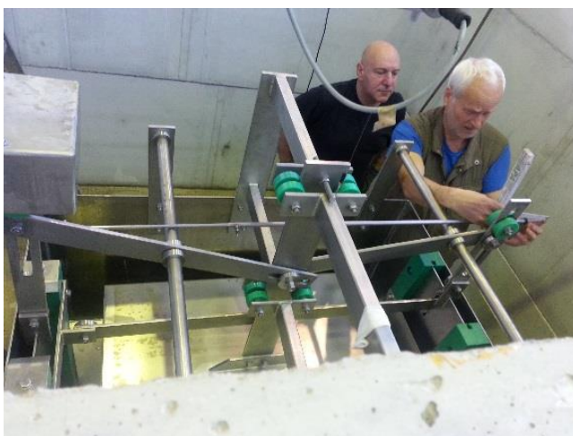
Bild 16 Feinjustierung am Gestänge des Abflussschiebers
