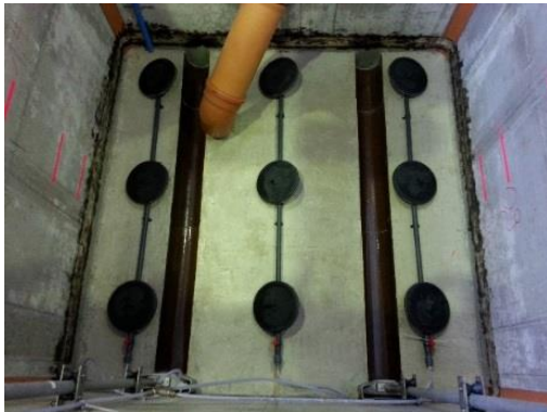
a) Anordnung der Belüftungsteller
