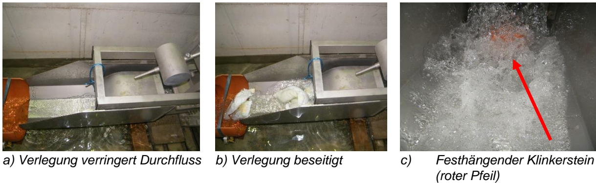
Bild 37 Beispiel für eine funktionierende Verlegebeseitigung der Waage-Drossel, hervorgerufen durch festhängende Windeln mit anschließendem Spülstoß; am Segmentschütz festhängender Klinkerstein
