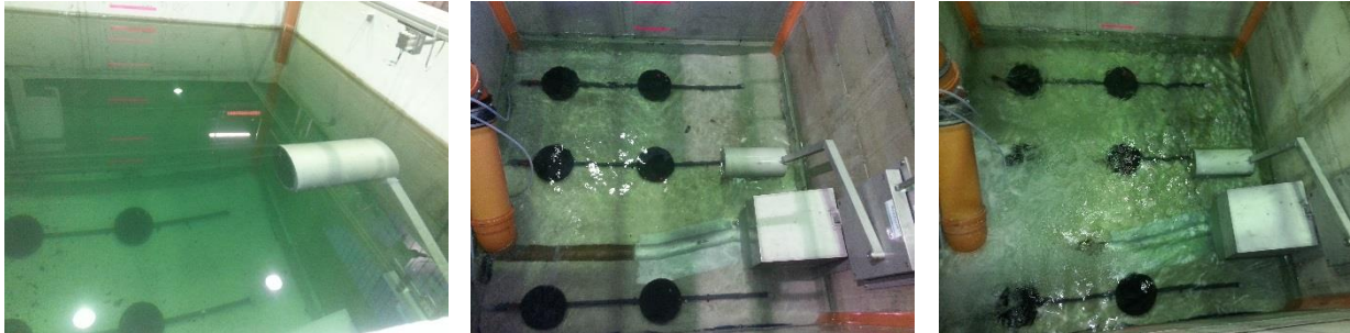
a) Voll eingestautes Regenbecken b) Drossel in Betrieb (SüwVO I) c) Wieder-Befüllen des Beckens
