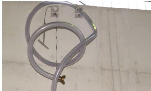
d) Befestigung von Reinigungsschlauch und Zugseil
