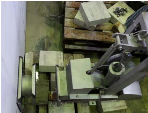
c) Einbringen des Drosselorgans mittels Kran
