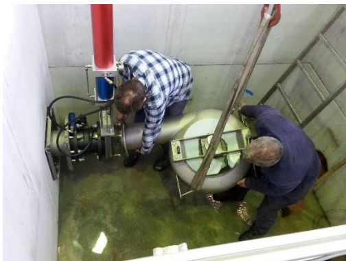
c) Einbringen des Drosselorgans mittels Kran
