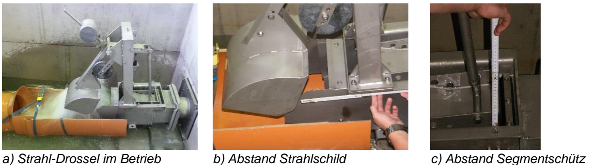
a) Strahl-Drossel im Betrieb b) Abstand Strahlschild c) Abstand Segmentschütz Bild 50 Strahl-Drossel während und nach der Durchführung der SÜwVO I-Prüfung (Ifd. Nr. 9 des Prüfprogramms)
