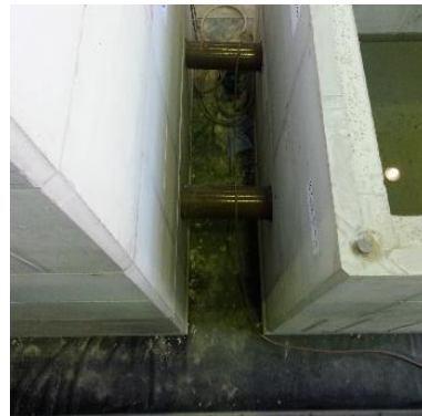
b) Verbindung Regenbecken mit Drosselschacht
