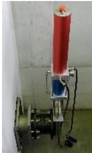
a) Hydraulikzylinder, Schieber b) Drosselorgan mit Auslauf Bild 58 Baugruppen/-teile der Turbo-Wirbeldrossel
