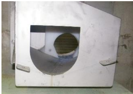
a) Montage der Querschnittsöffnung
