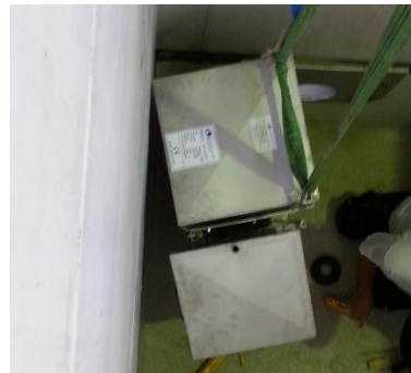
b) Einbringen des Drosselorgans mittels Kran
