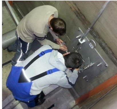
b) Verstellen des Hebelarms
