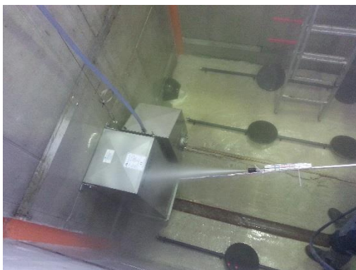
a) Hochdruck-Reinigung der Drossel
