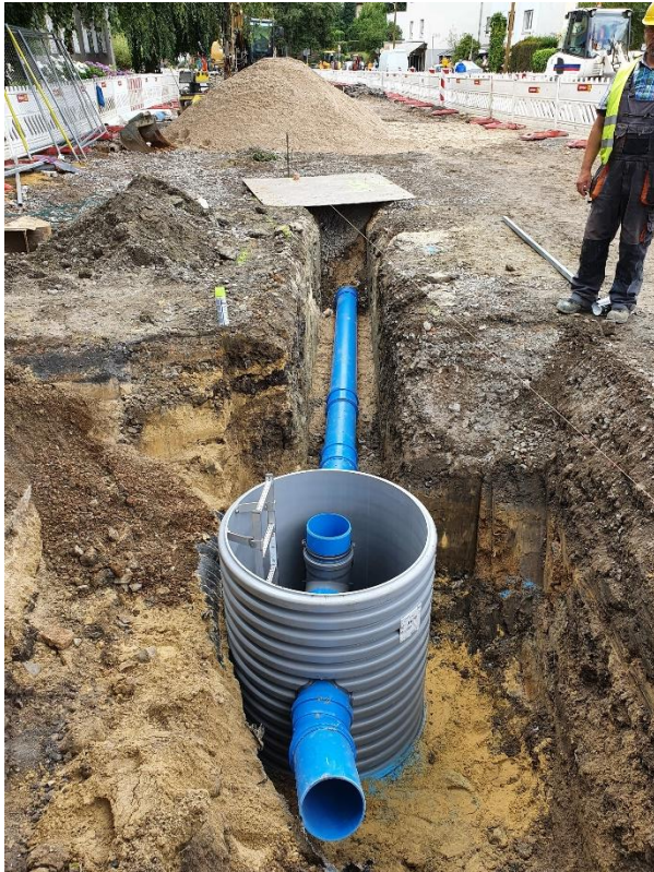
Abb. 18 u. 19: Drosselschächte erhöhen die Einstauleistung im Strang
