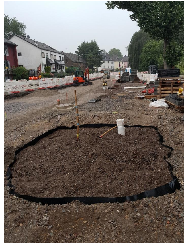
Abb. 21: fertig gestellte Baumrigole
