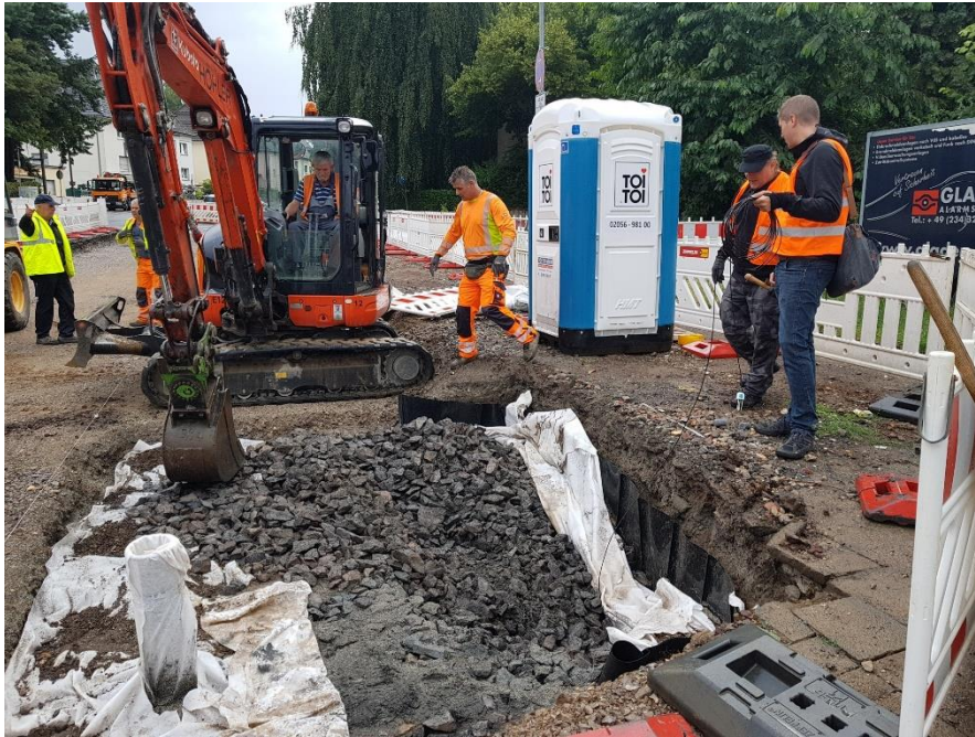
Abb. 22 u. 23: Einbau Messtechnik Monitoring in 2 Tiefenlagen (Messung Temperatur u. Bodenfeuchte), Ruhr-Uni-Bochum
