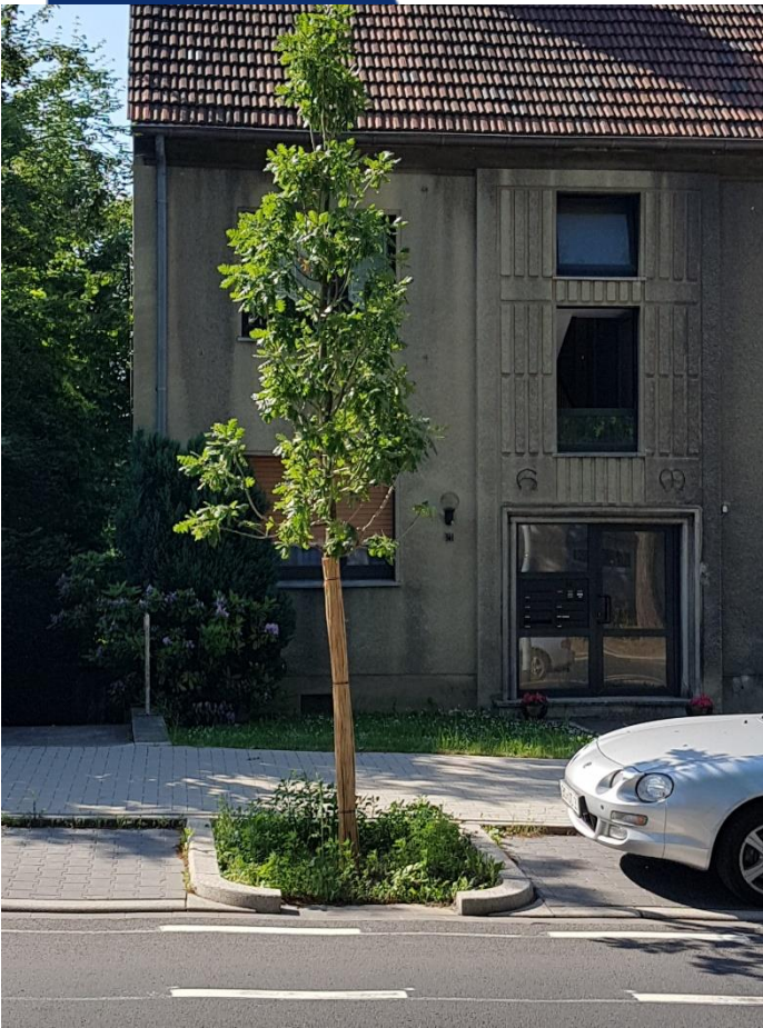
Abb. 24 u. 25 : Fertiggestellte Baumrigole u. Regenrückhalte- / Verdunstungsbecken
