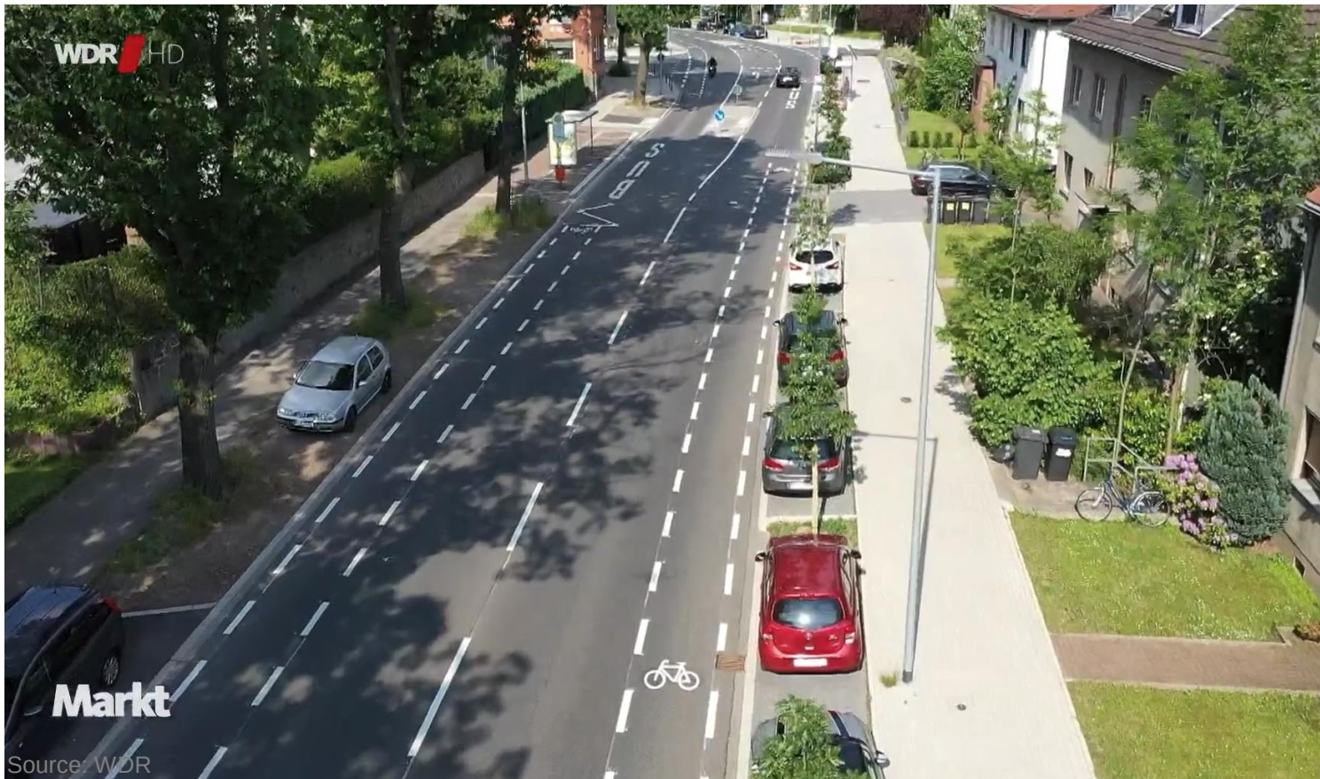
Abb. 26: Fertiggestellte 18 vernetzte Baumrigolen Wasserstr.
