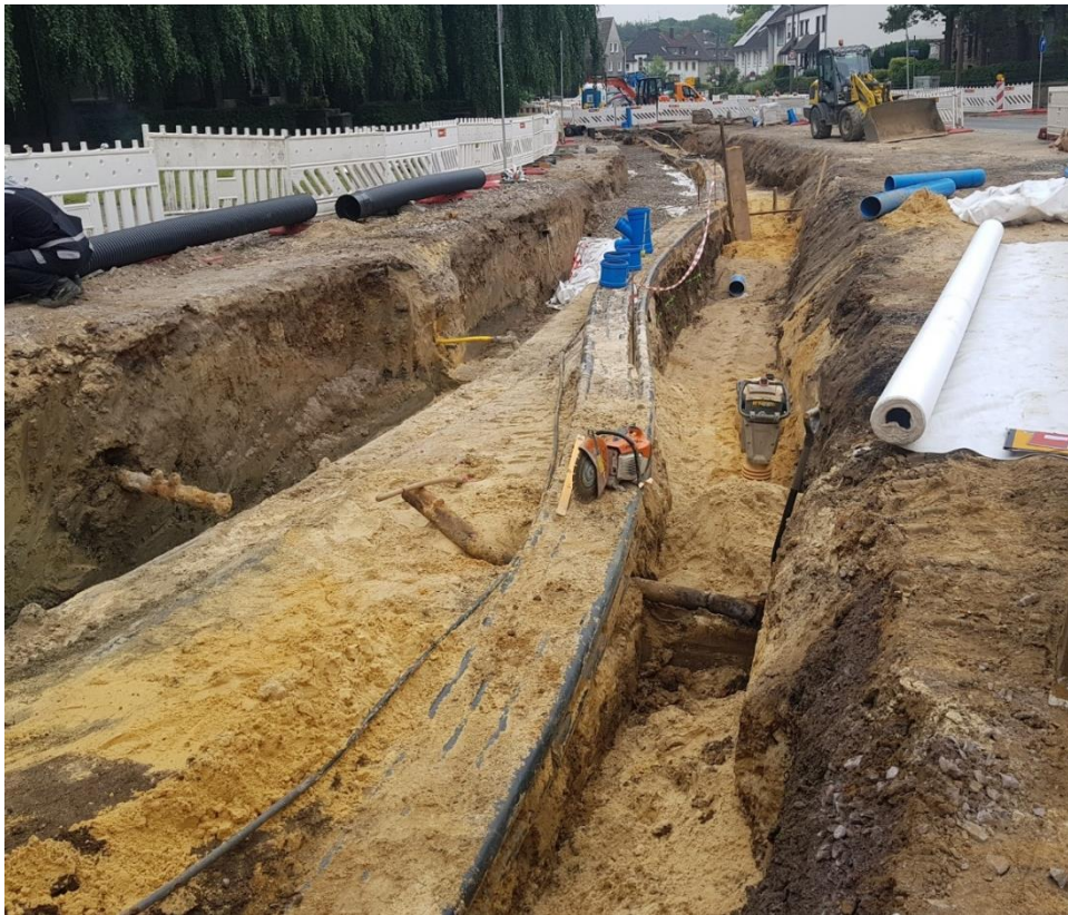
Abb. 12 u. 13: Rigolenabschnitt mit Bypass
