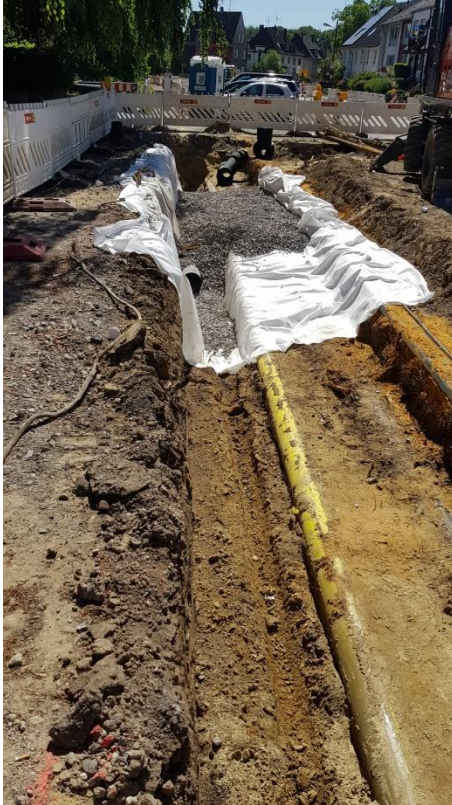
Abb. 14: Rigolenabschnitt neben Versorgungsleitungen
