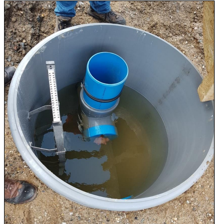
Abb. 18 u. 19: Drosselschächte erhöhen die Einstauleistung im Strang
