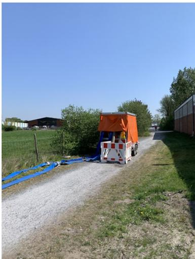
Beim Ausfall des Notstromaggregates steht im beim Kanalbetrieb eine mobile Drehkolbenpumpe mit einer Förderleistung von 300 m<sup>3</sup>/h als Redundanz zu Verfügung.
