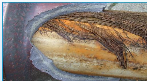
Der Liner ist wurzeldicht. Die Wurzeln konnten sich nur zwischen Liner und Altrohr ausbreiten.
