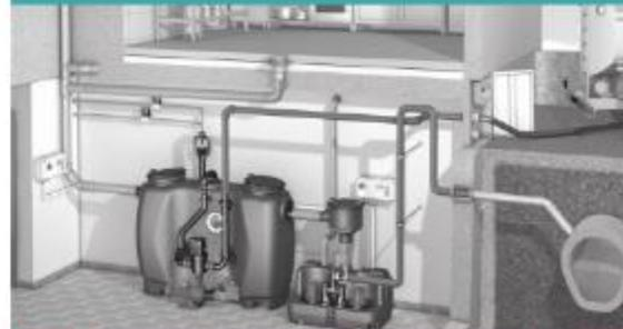
Im Keller eingebauter Fettabscheider - Anlage wird nach der Kontrolle über einen Saugwagen geräumt.
