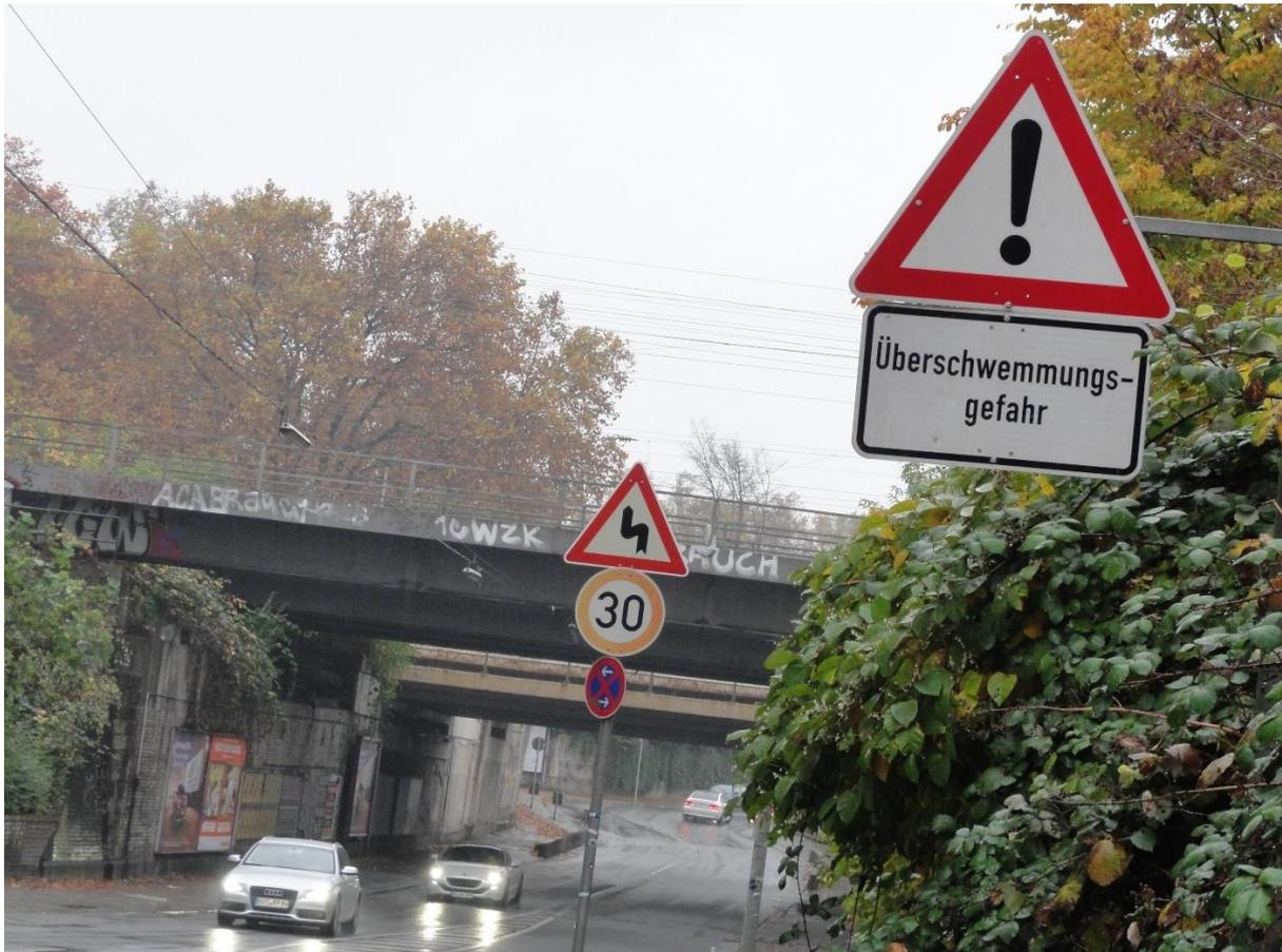
Abbildung 2-1: Beispiel einer Unterführung in Gelsenkirchen mit Verkehrsschild "Gefahrenstelle" nach StVO Verkehrszeichen-Nr. 101 mit Zusatzzeichen "Überschwemmungsgefahr" [Quelle IKT]
