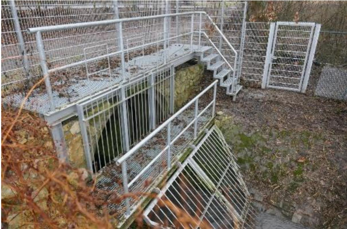
Abbildung 2-2: Beispiel eines Rechens vor einem Rohrdurchlass in Münster [Quelle IKT]
